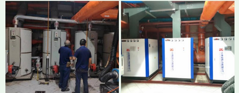
锅炉改造前后
