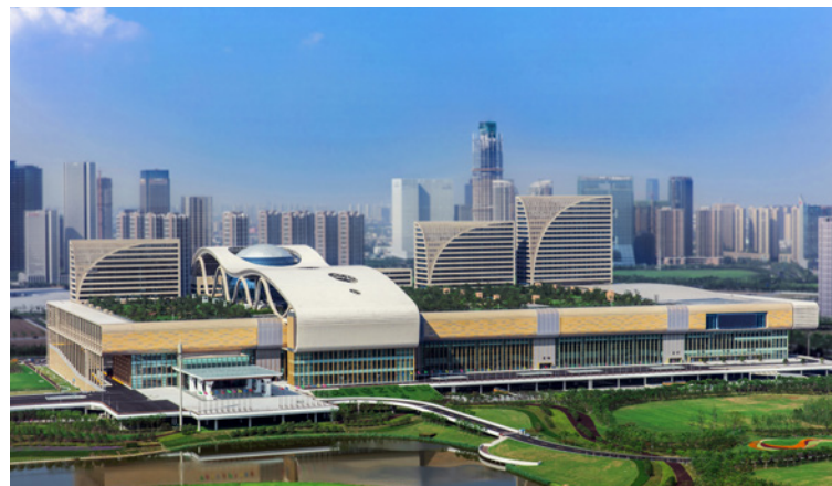
杭州国际博览中心
