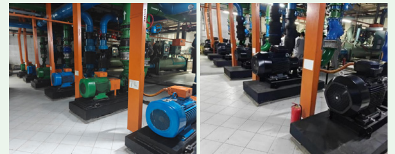
循环水泵改造前后
